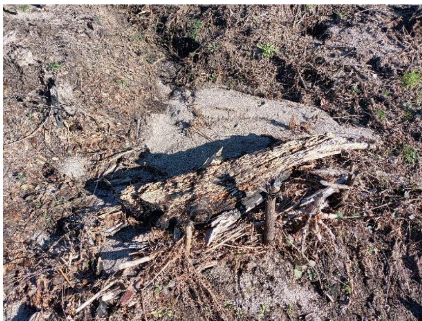
Figura 14. Barreira com madeira (paliçada) já com acumulação de sedimentos.
