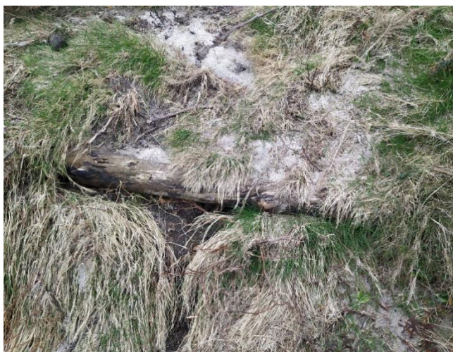
Figura 2. Barreira construída em 2018, e a resultante acumulação de sedimentos.
